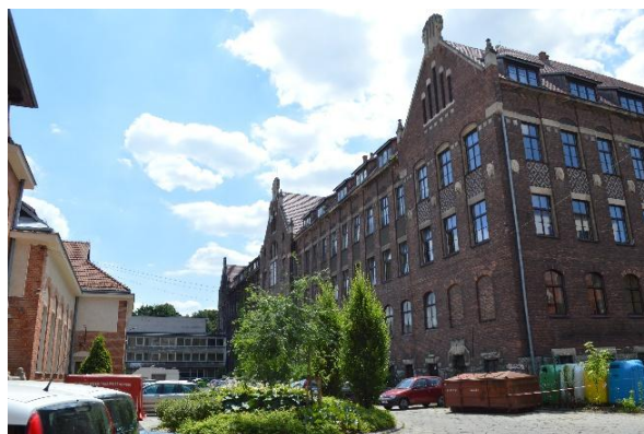
Fot. 25. Budynek Zespołu Szkół Mechanicznych.
