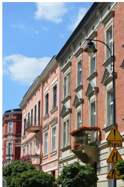
Fot. 27. Odrestaurowane fasady kamienic.
