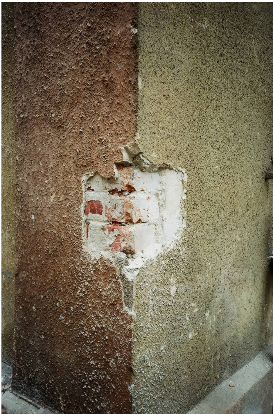
II. 28 Odkrywki, budynek B, narożnik południowo-wschodni; po prawej widoczny jest pierwotny narzut tynkowy.
