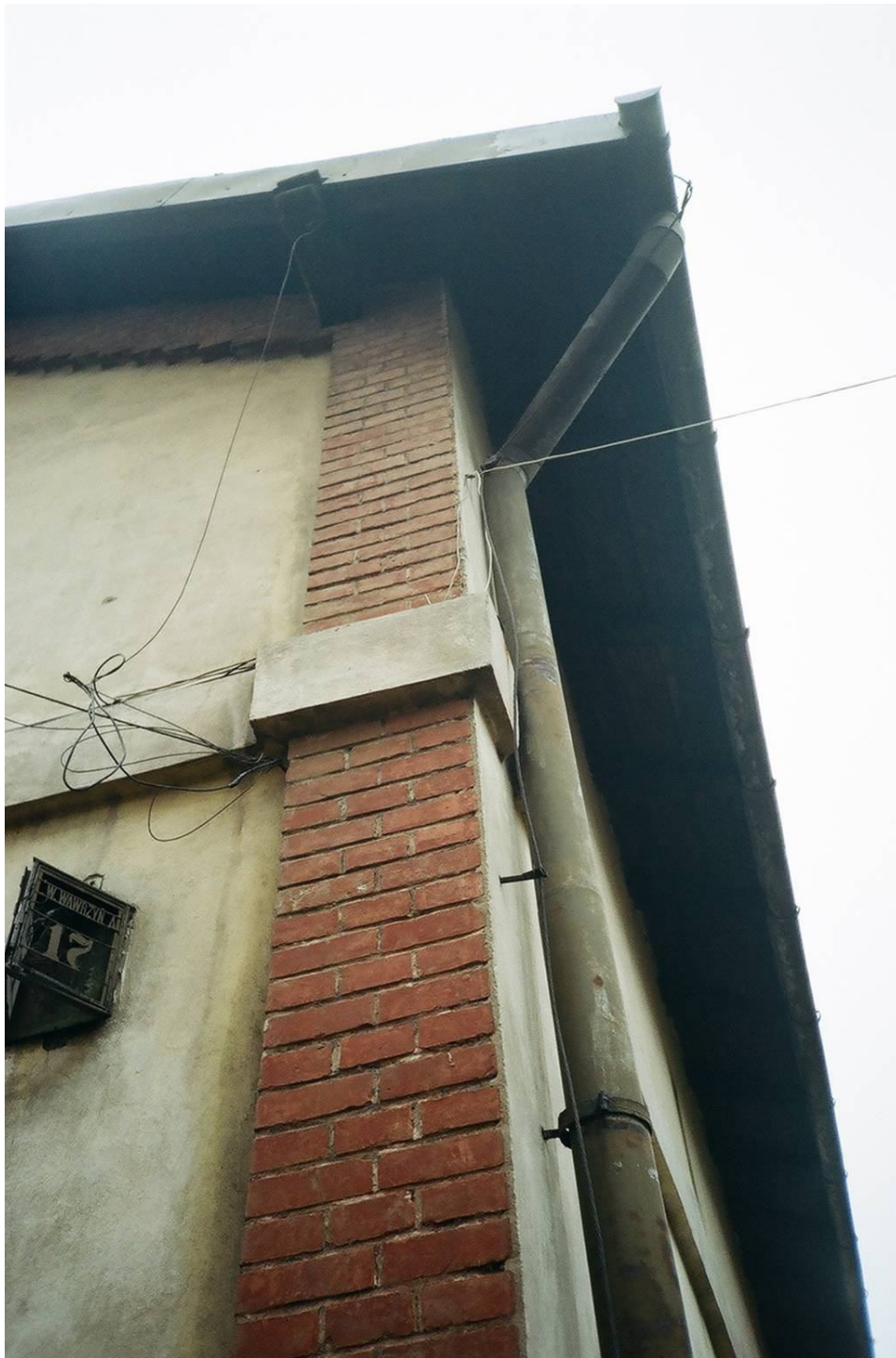
II. 32 Odkryte wątki ceglane, budynek C, elewacja północna, narożnik zachodni - lizena i fragment otynkowanego gzymsu kordonowego.
