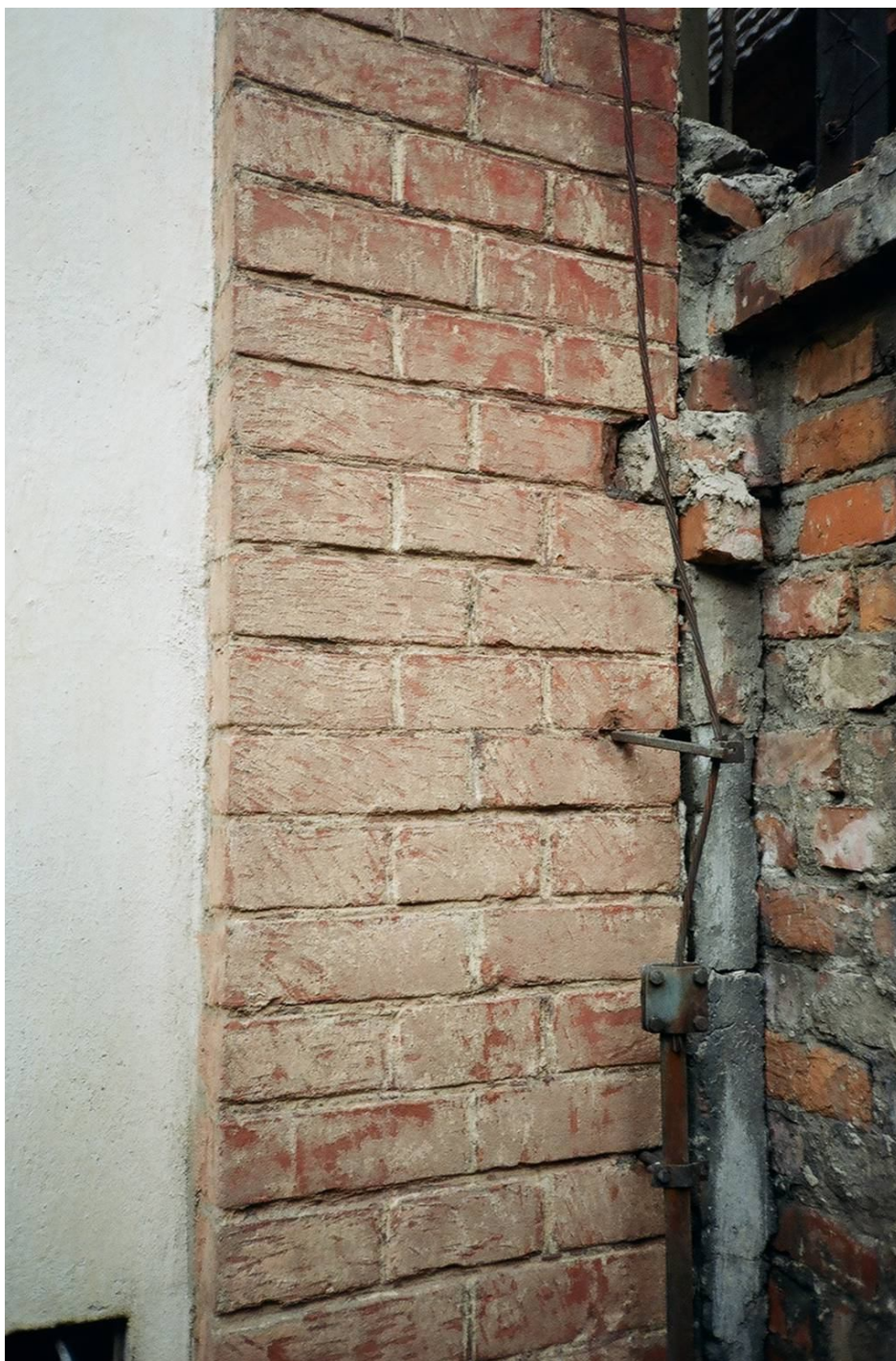
II. 35 Odkryte watki ceglane, budynek C, elewacja poudniowa, naronik wschodni – fragment lizany.
