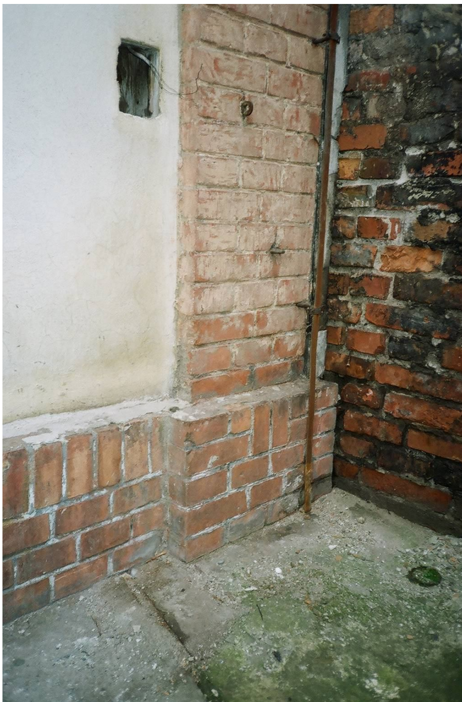
II. 34 Odkryte wątki ceglane, budynek C, elewacja południowa, narożnik wschodni – cokół i lizena.
