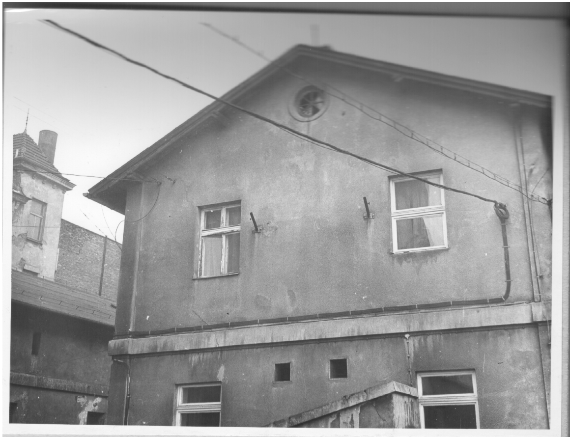
II. 8 Budynek B, elewacja północna (fotografia z 1984, KPG).
