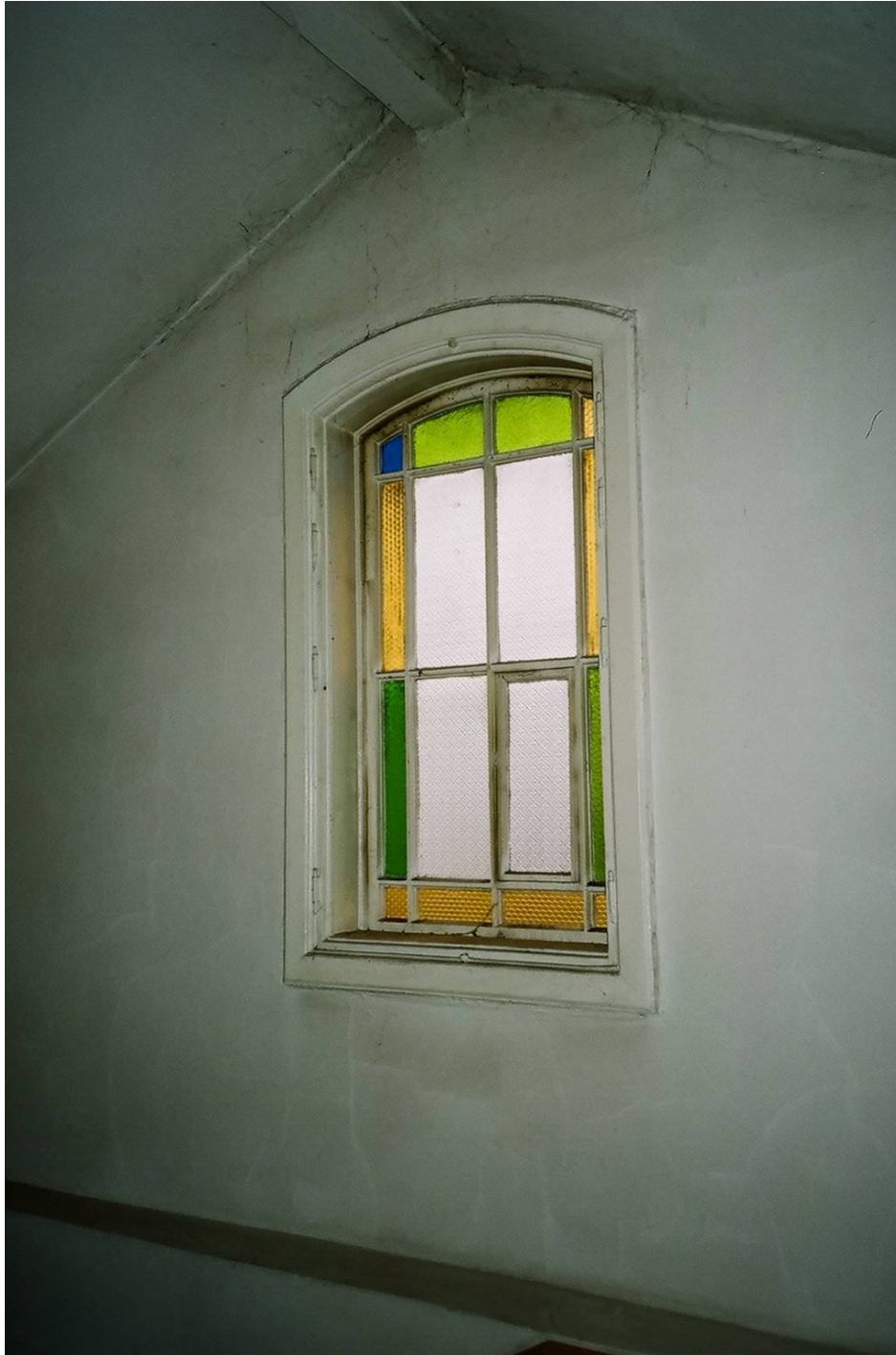
II. 18 Budynek B, wewnątrz klatki schodowej – stolarka okienna w ścianie zachodniej (1882?).
