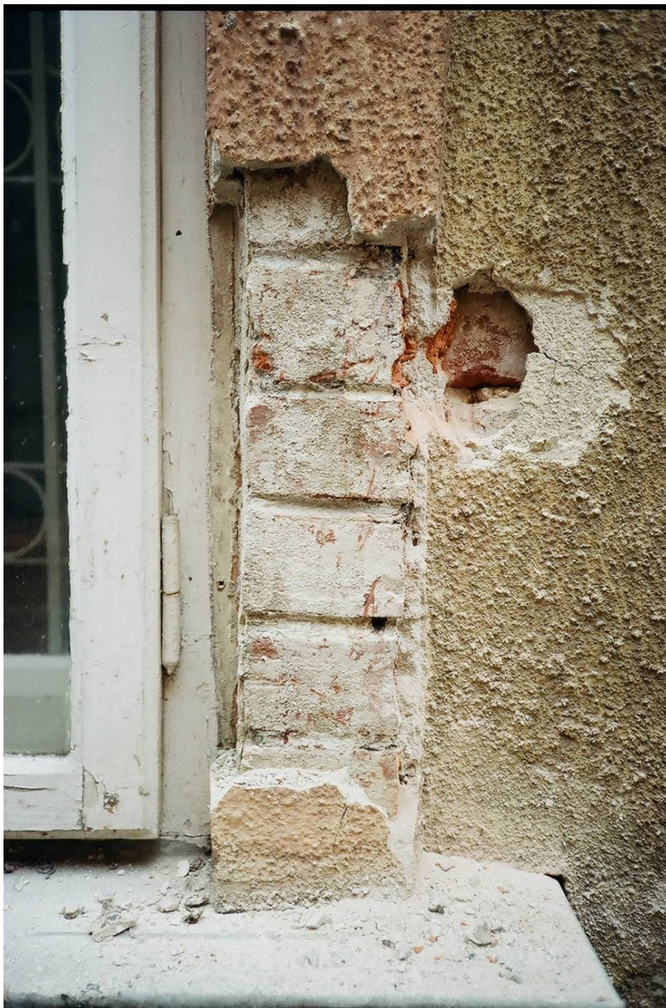
II. 30 Odkrywki, budynek B, elewacja południowa, fragment opaski okiennej.
