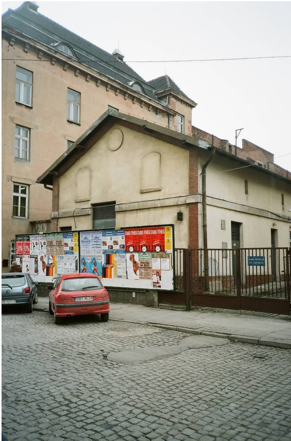
II. 20 Budynek C, stan dzisiejszy, elewacja północna i fragment elewacji zachodniej.
