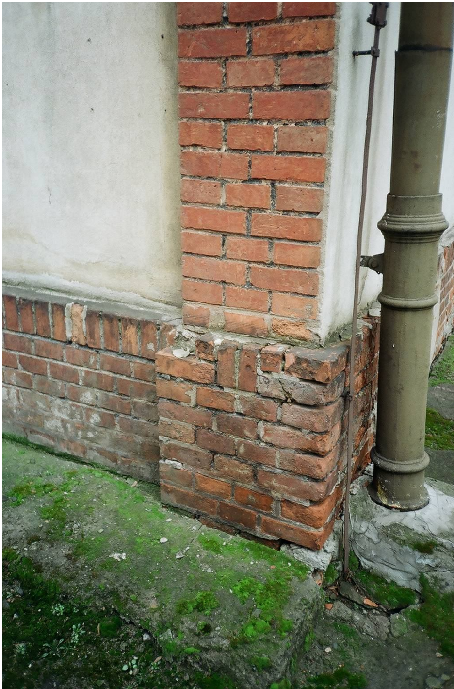
II. 31 Odkryte wążki ceglane, budynek C, elewacja północna, narożnik zachodni - cokół i lizena.
