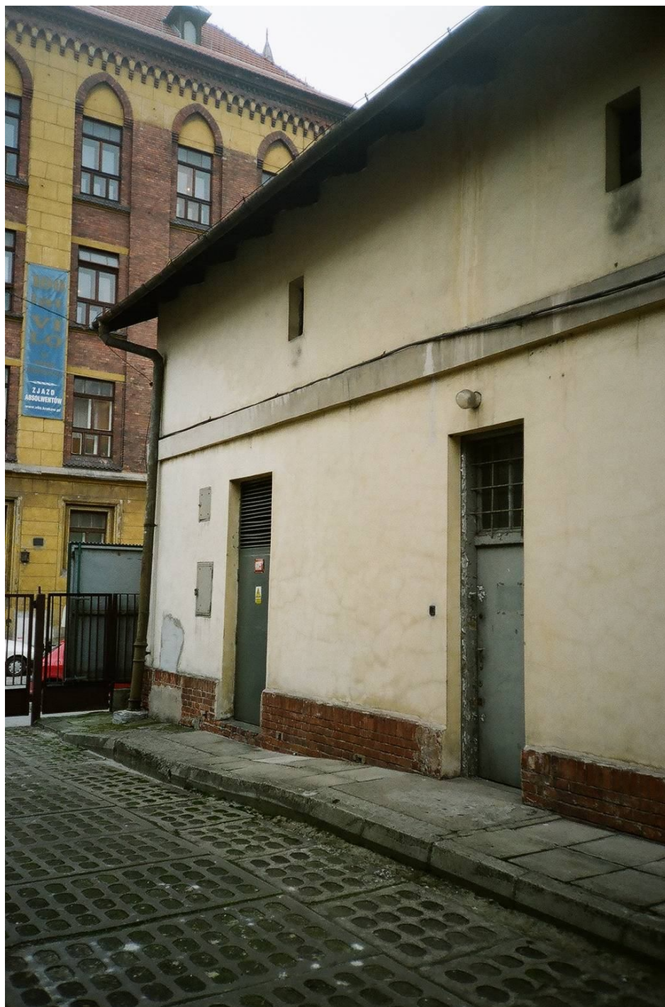
II. 24 Budynek C, stan dzisiejszy, północna partia elewacji zachodniej.
