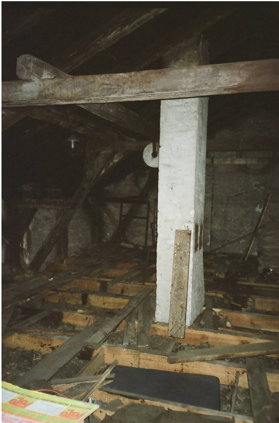
II. 26 Budynek C, stan dzisiejszy, wewnątrz strychu widok w kierunku północnym.
