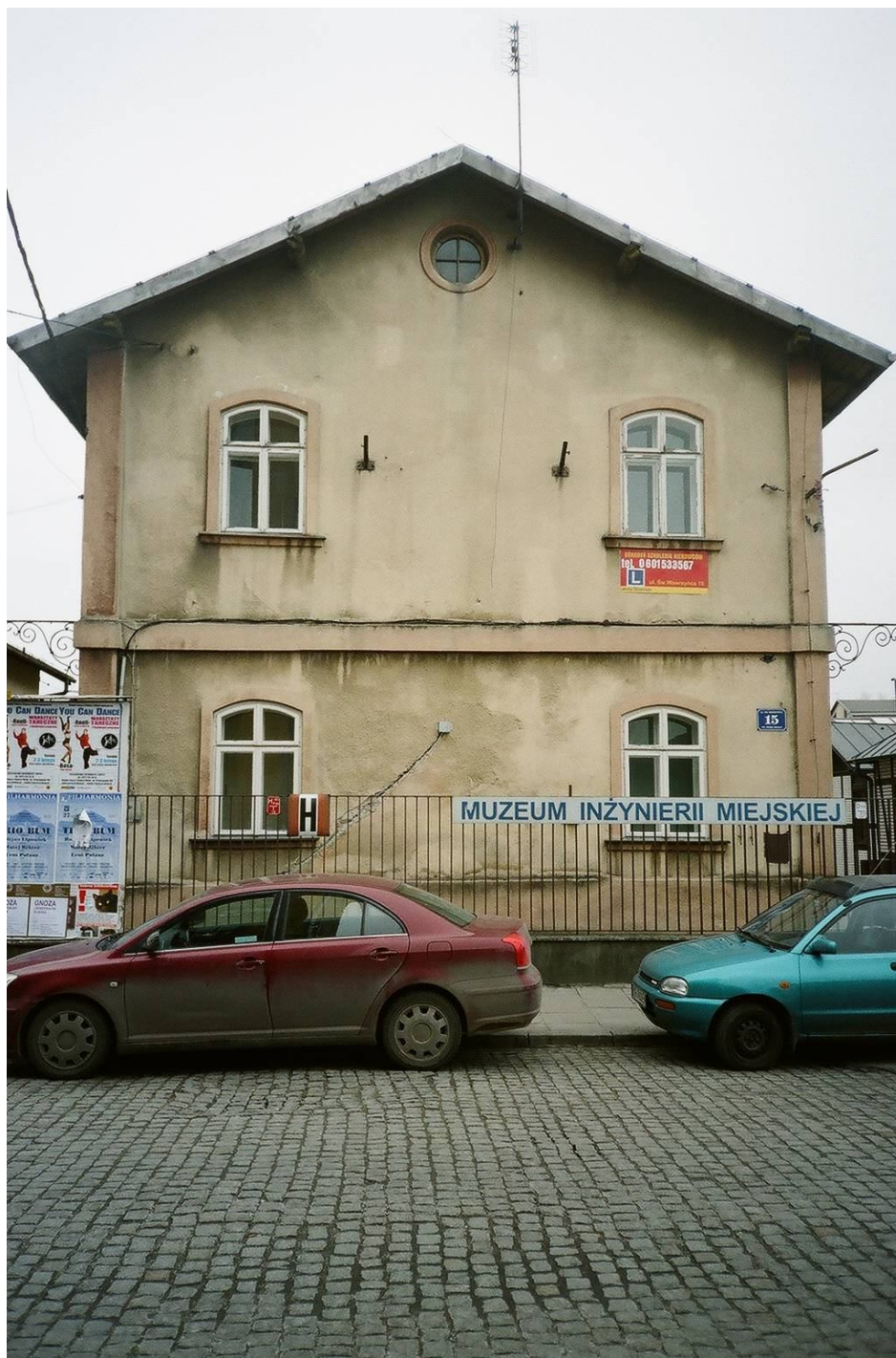
II. 15 Budynek B, stan dzisiejszy, elewacja północna.
