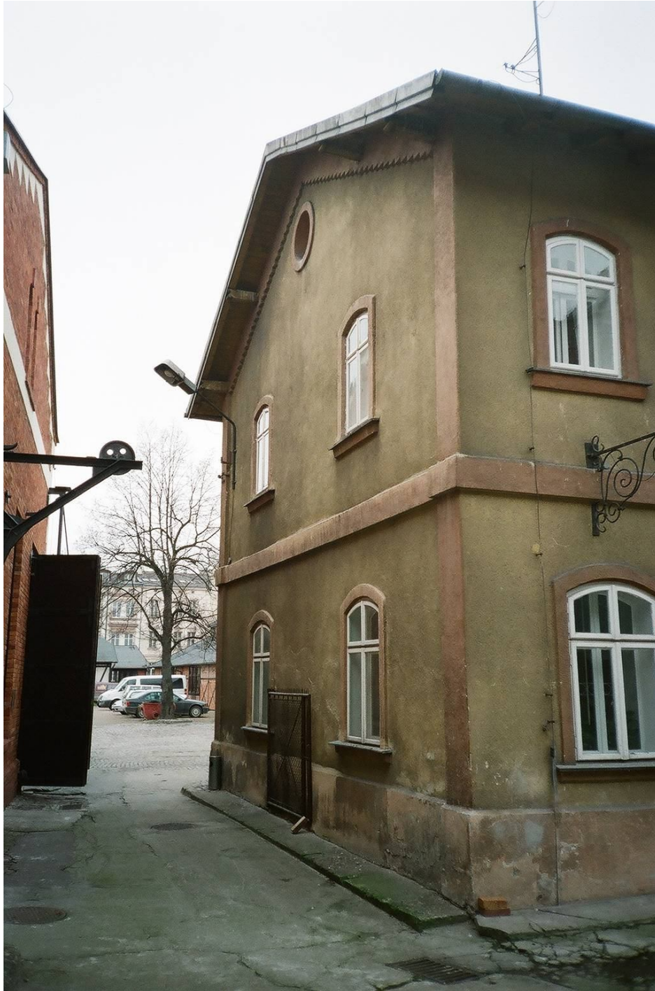
II. 16 Budynek B, stan dzisiejszy, narożnik południowo-wschodni i elewacja południowa.
