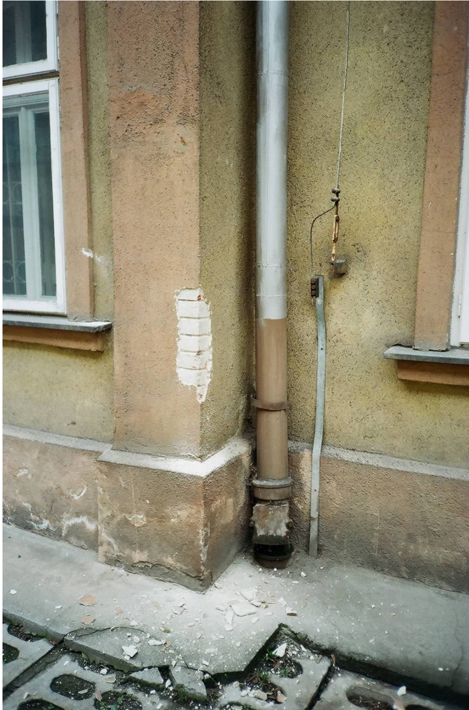
II. 29 Odkrywki, budynek B, elewacja wschodnia, północna lizena centralnego ryzalitu.
