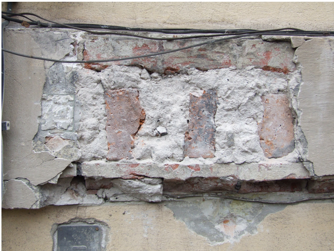
II. 36 Odkrywki, budynek C, elewacja południowa, zachodni fragment gzymsu kordonowego.
