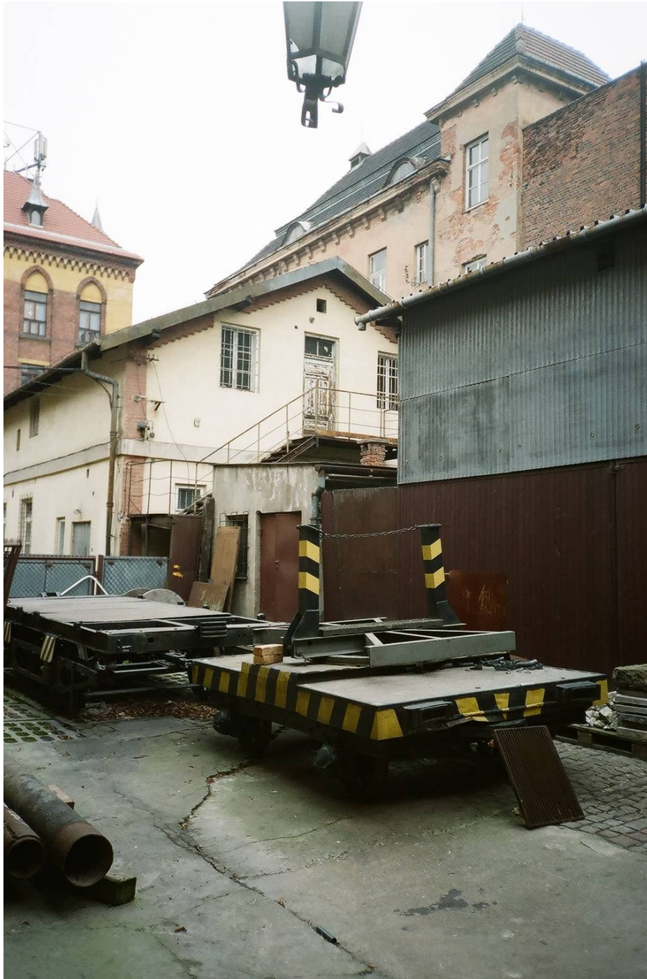
II. 22 Budynek C, stan dzisiejszy, elewacja południowa i fragment elewacji zachodniej.
