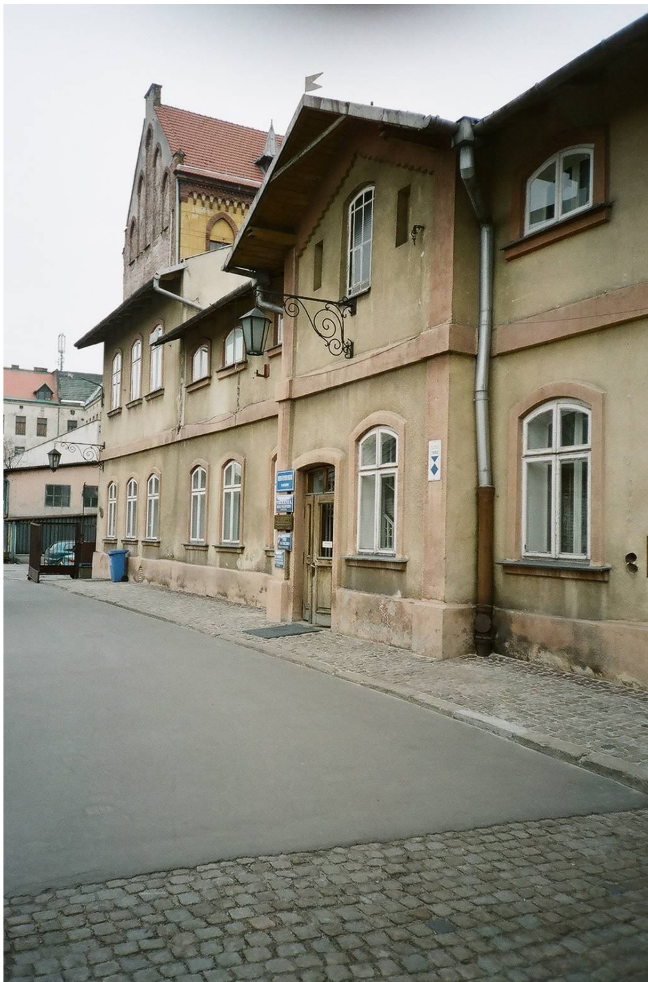
II. 9 Budynek B, stan dzisiejszy, elewacja zachodnia – ryzalit na osi i partia północna.
