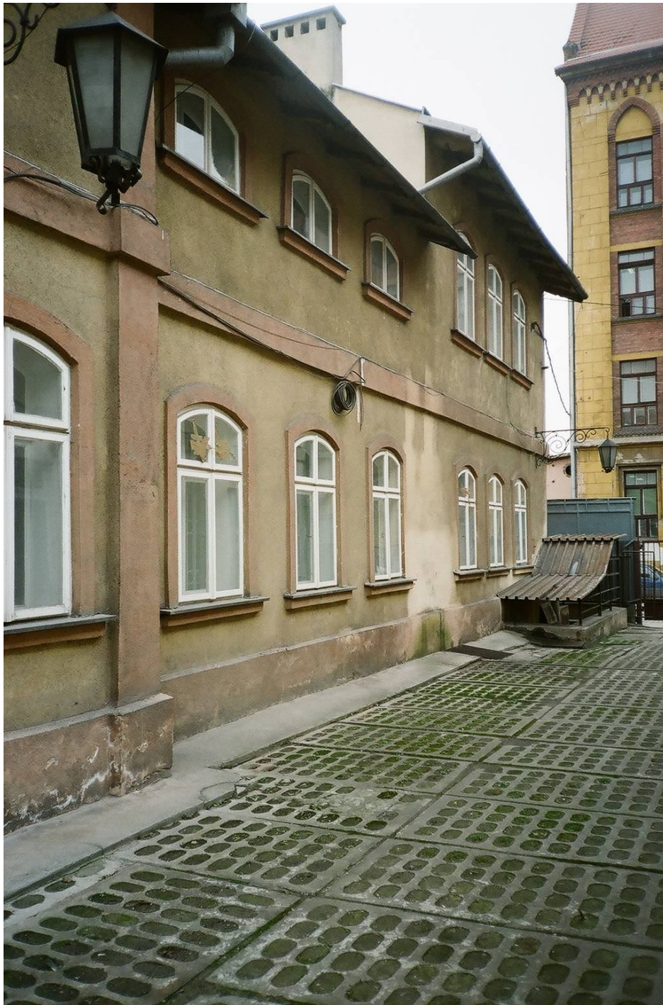
II. 13 Budynek B, stan dzisiejszy, elewacja wschodnia – północna partia elewacji (w głębi widoczne jest zadaszenie zewnętrznych schodów do piwnicy), po lewej fragment centralnego ryzalitu.
