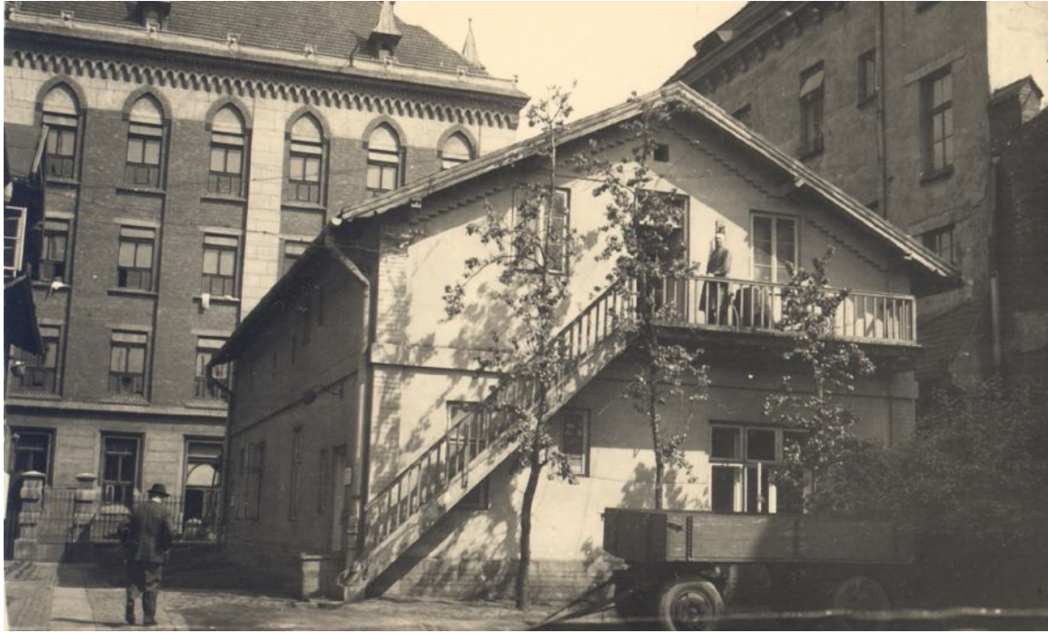
II. 7 Budynek C, elewacja południowa z pierwotnymi schodami na poddasze (drewnianymi) oraz w silnym skrócie elewacja zachodnia (reprodukcja fotografii z lat międzywojennych, ze zbiorów Muzeum Inżynierii Miejskiej).
