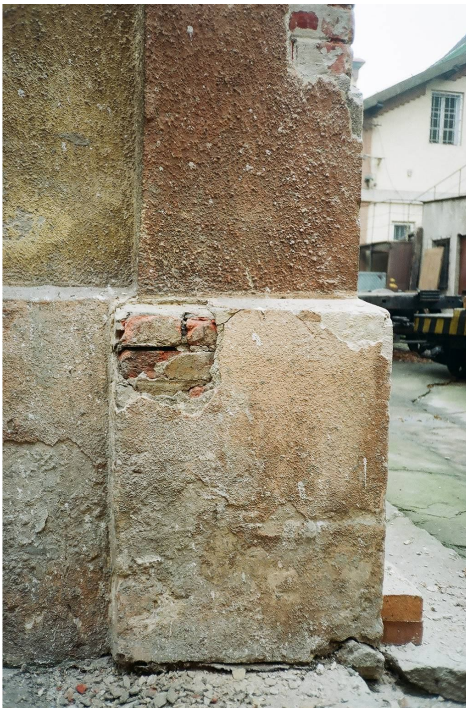
II. 27 Odkrywki, budynek B, narożnik południowo-wschodni, cokół.
