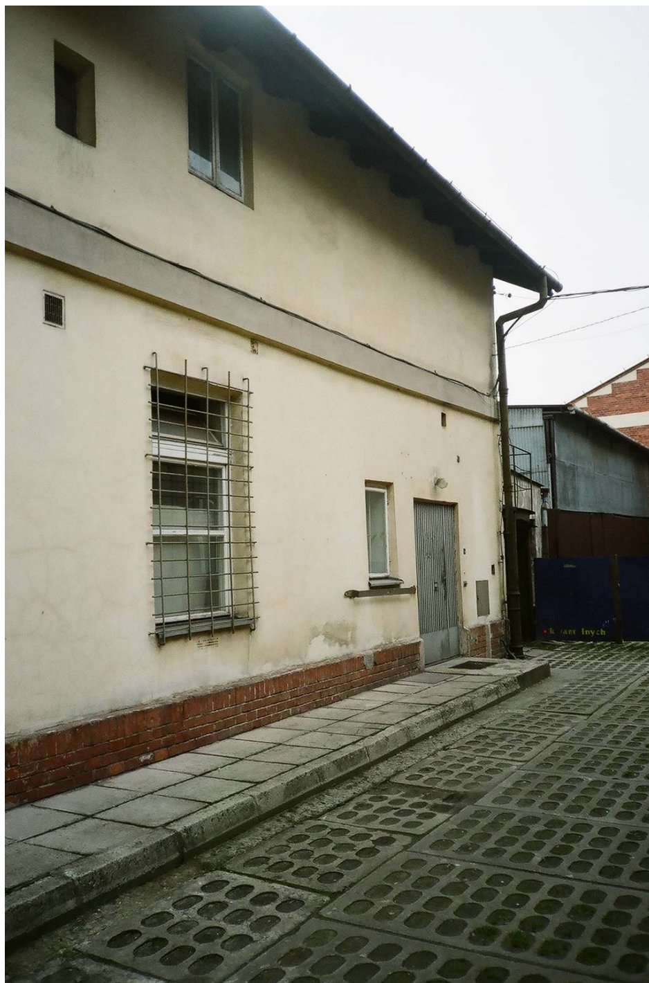
II. 25 Budynek C, stan dzisiejszy, południowa partia elewacji zachodniej.
