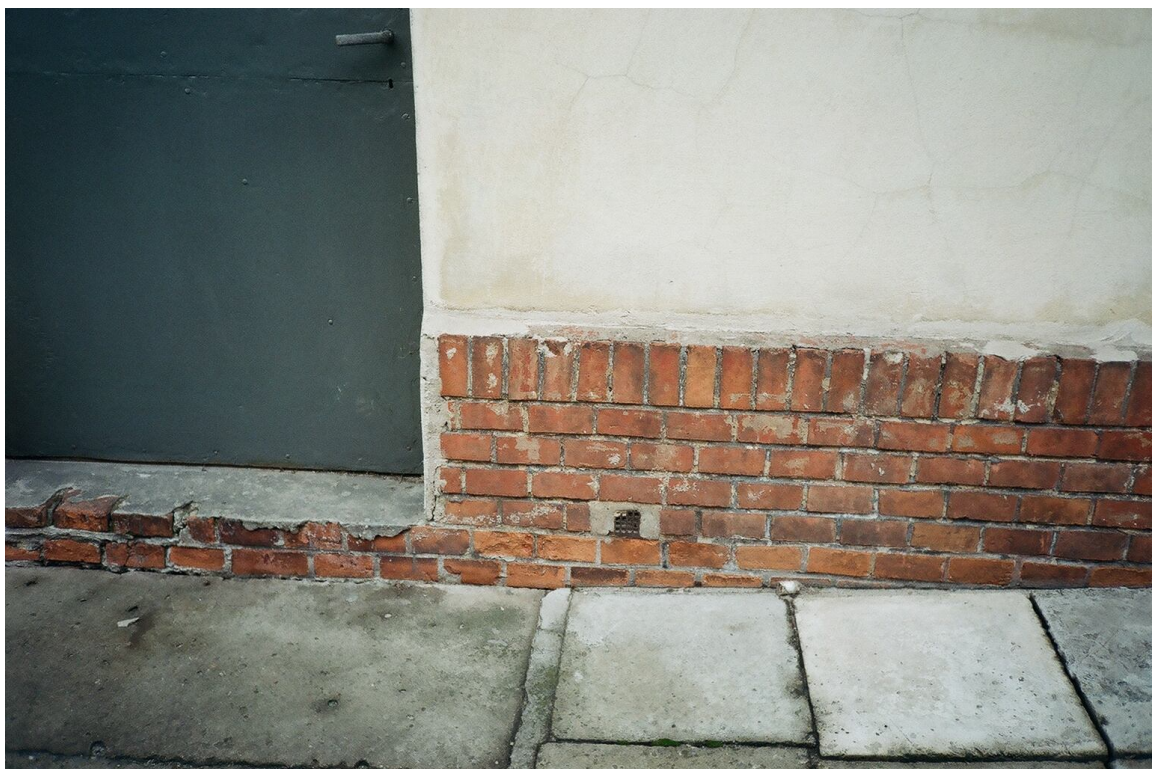
II. 33 Odkryte wątki ceglane, budynek C, elewacja zachodnia, cokół.
