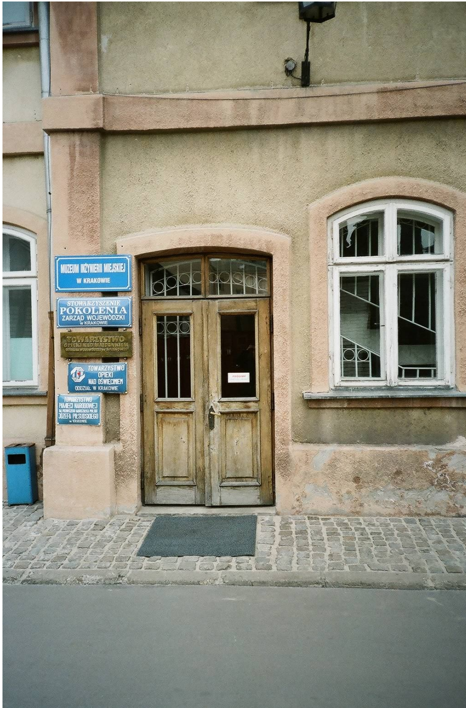
II. 11 Budynek B, stan dzisiejszy, elewacja zachodnia – ryzalit na osi w parterze, stolarka drzwiowa i okienna.
