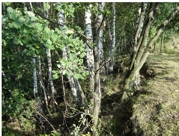
Fot.3. Osuwająca się krawędź progu opadającego ku ul. Olszanickiej.
