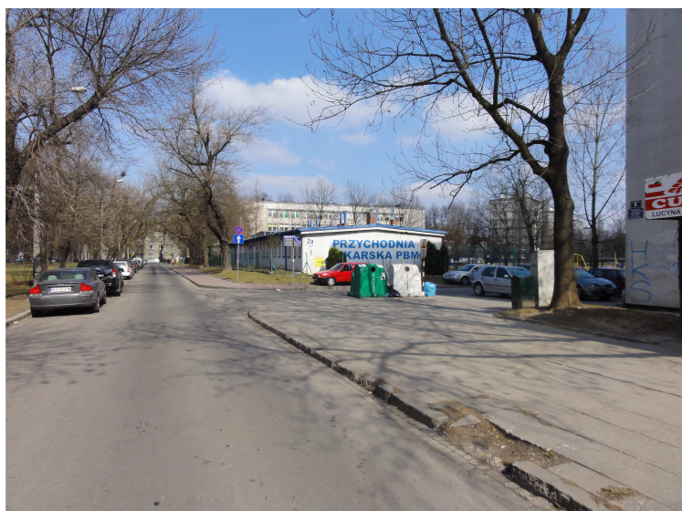
Fot. 3. Widok w głąb ul. Gardy-Godlewskiego, w planowanym terenie MWs.8.1, przy Parku Ratuszowym. Na zdjęciu widoczny parterowy budynek, z możliwością rozbudowy i nadbudowy do 19m wys. (zdjęcie inwentaryzacyjne, BPP UMK).
