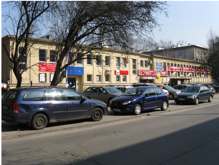
Fot.4. Istniejący budynek (teren MWn/U.4.3). Ustalona w planie maksymalna wysokość zabudowy – 18 m, umożliwi wybudowanie w tym miejscu obiektu 5-6 kondygnacyjnego (zdjęcie inwentaryzacyjne, BPP UMK).
