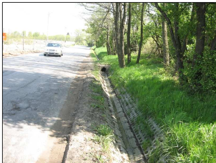
Fot.4. Przykład odnowionego rowu odwadniającego – okresowo czynnego
