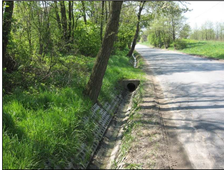
Fot.3. Przykład odnowionego rowu odwadniającego – okresowo czynnego
