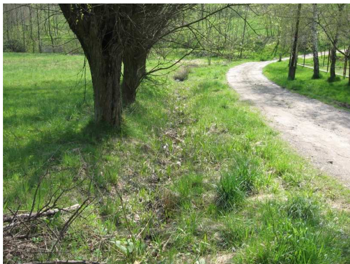
Fot.2 Przykład „zanikającego rowu” – częste w rejonie Swoszowic odprowadzenie wód opadowych na obszarach, gdzie nie ma jezdni typu ulicowego
