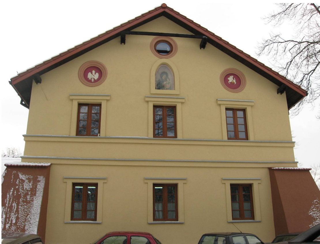
FOT. 1 GŁÓWNY DOM ZDROJOWY- RYZALIT BOCZNY
