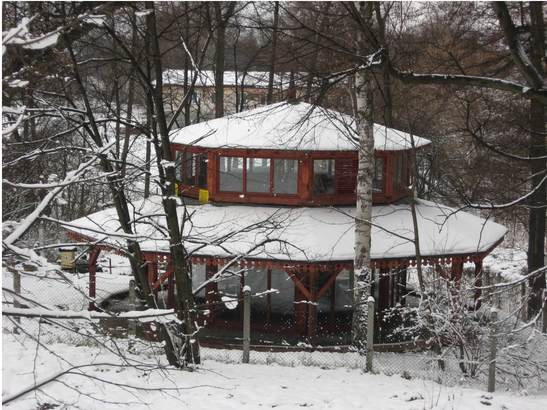
FOT.3 GLORIETA- NAZIEMNA OBUDOWA UJĘCIA „ŹRÓDŁO GŁÓWNE”
