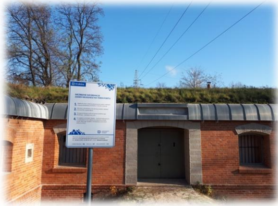
Fot. 5. Fort Mogiła
