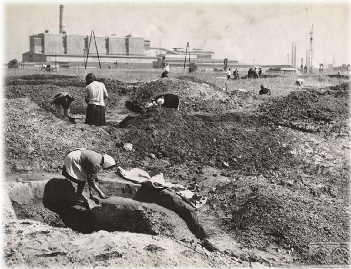
Fot. 3. Wykopaliska archeologiczne prowadzone na terenie kombinatu
