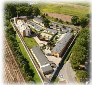
Fot. 16. Zakład karny Kraków – Nowa Huta Źródło: www.sw.gov.pl
