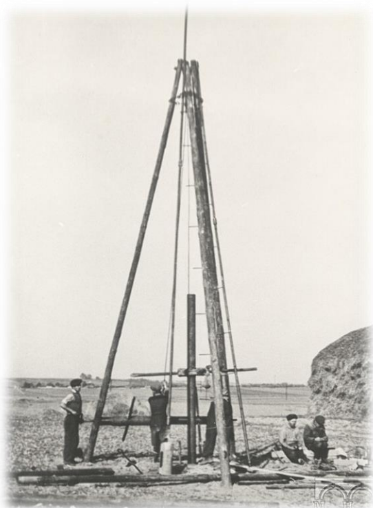
Fot. 1. Pierwsze prace przy budowie kombinatu Źródło: MHK, MHK-197/XI f
