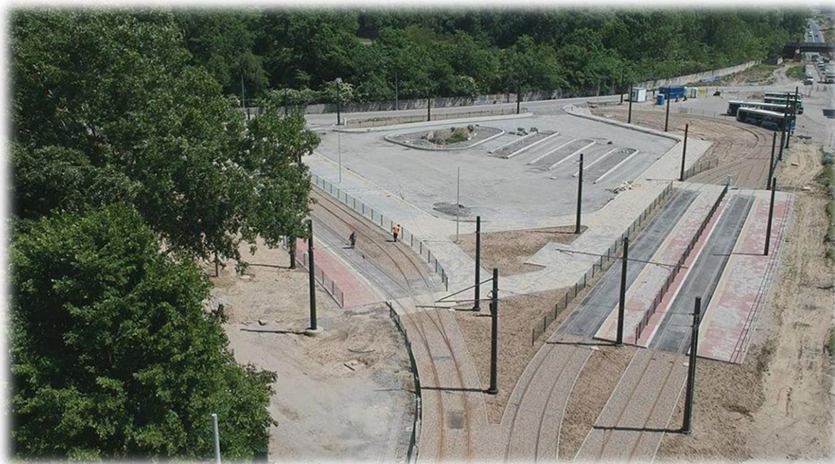
Fot. 18. Zmodernizowana pętla w Pleszowie
