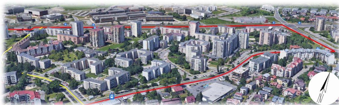
Rysunek 3 Północna część analizowanego obszaru
