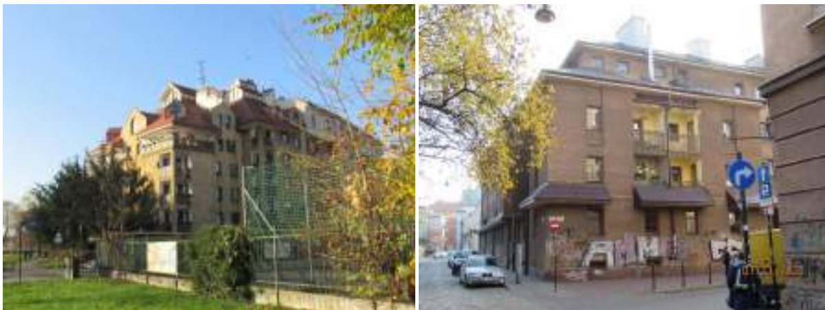
Budynek przy ul Wietora 17 // budynek przy ul Jakuba/Warszauera
