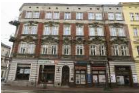
Zabudowa mieszkalna XIX w.
