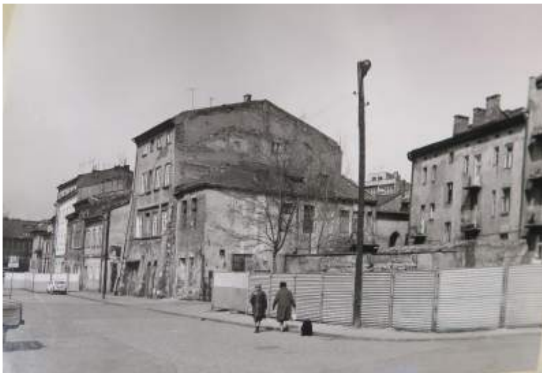
Lata 80-te XX w. – stan zachowania – wyburzenia (z dokumentacji PP PKZ, 1985)
